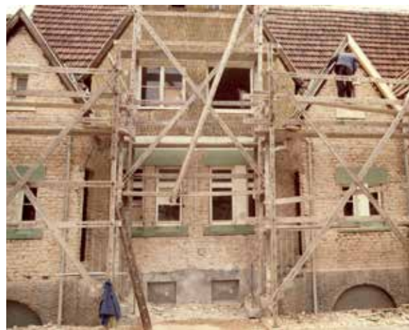
Abb. 5 Cramer-Klett- Platz 7 und 9; Sanierung im Jahre 1983
